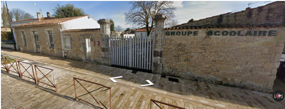
Façade Rue de la Commanderie
